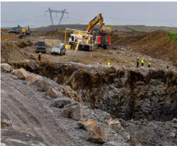
Morgunblaðið/Árni Sæberg Vinna Unnið að gerð frávinnsluskurðar vegna Hvammsvirkjunar.
