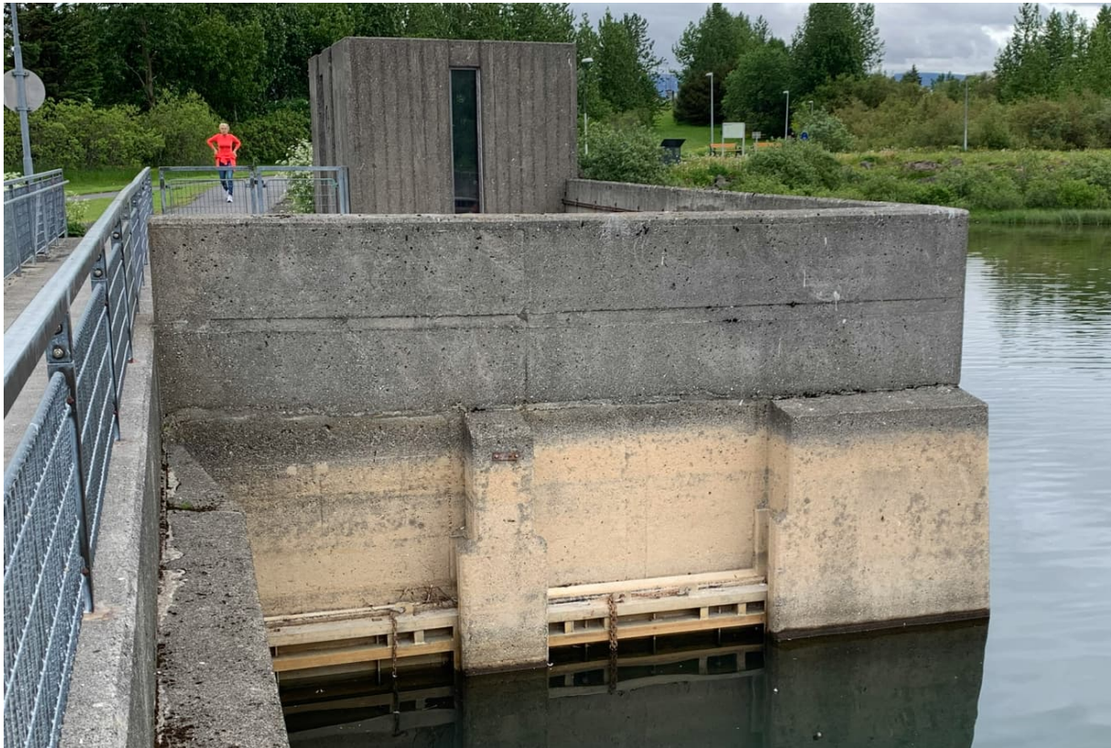
Mynd 19 Inntak, horft til norðurs. Inntakslokur sýnilegar upp úr vatni.
