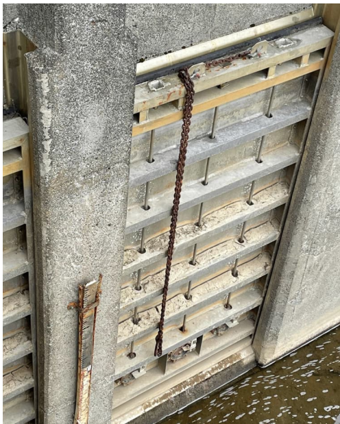
Mynd 24 Vara inntakslokur
