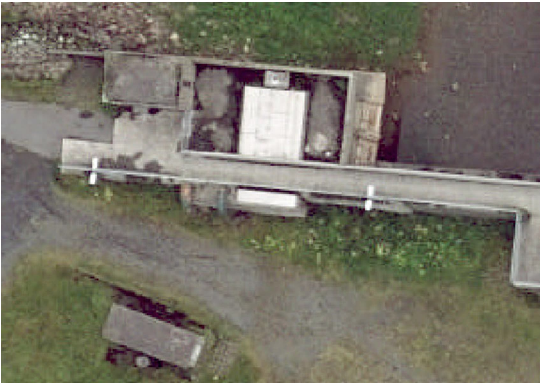
Mynd 17 Inntak, loftmynd.
